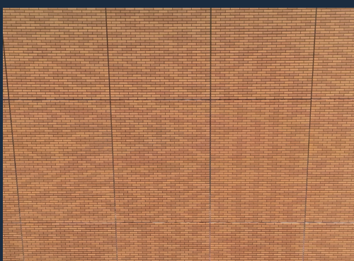
漏水・浸水 検出の例
